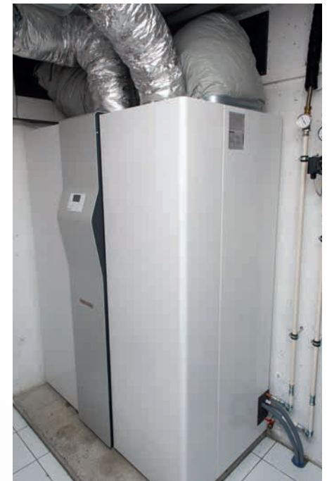
Installation mit ISG, für die einfache Bedienung der Wärmepumpe.
